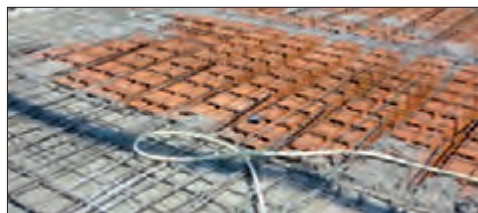
Solaio in laterocemento gettato in opera
