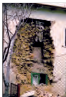
Fig. 3.2 – Ps: sezione a paramenti con elementi scollegati o male ammassati come evidenziato da crolli rovinosi provocati dal sisma
