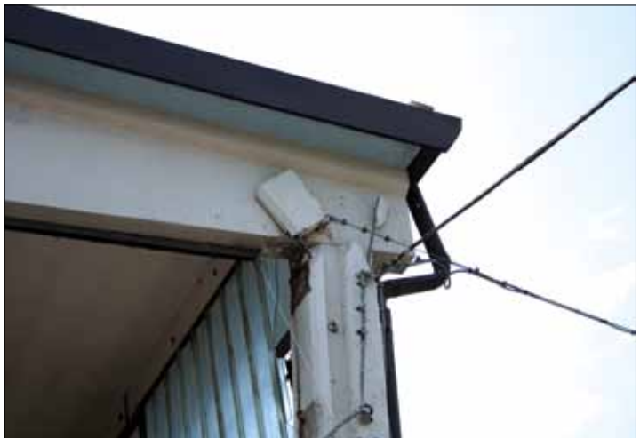
Figura 5.20: Collasso della forcella in testa al pilastro in corrispondenza dell'appoggio della trave di copertura. Livello di danno nella connessione trave-pilastro: D4-D5 (terremoto Emilia-Romagna 2012, San Felice sul Panaro, MO)
