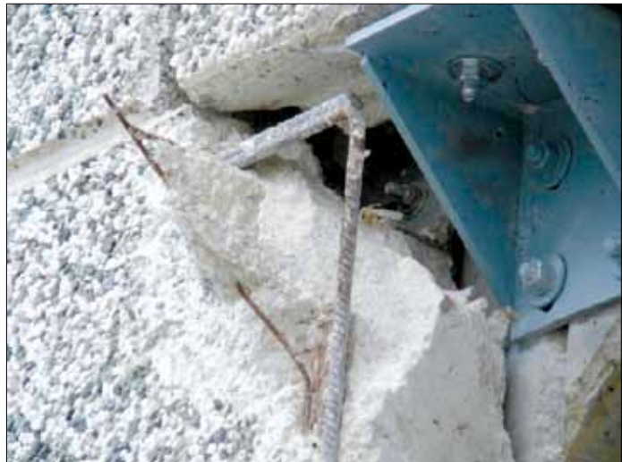
Figura 5.33: Rottura dello spigolo del pannello per insufficiente armatura ed effetto di martellamento. Livello di danno: D3 (terremoto Abruzzo 2009, Centro commerciale, L'Aquila)
