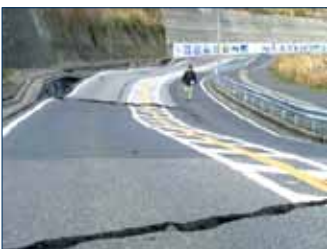
Figura 7.10: Distorsione differenziale della pavimentazione stradale in una zona residenziale di Mihama di Chiba (Giappone 2011)
