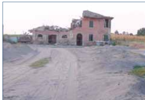
Figura 7.14: Esempi di liquefazione (terremoto Emilia-Romagna 2012)
