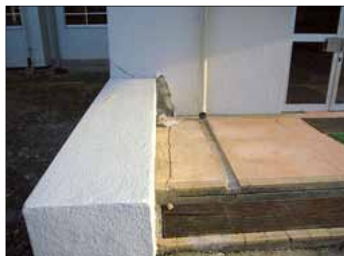
Figura 7.2: Fessurazione alla base dell’edificio (Foto: Y. Sakai) (Giappone 2011)
