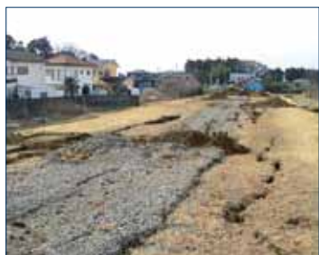
Figura 7.11: Spostamento laterale dovuto a liquefazione di un terrapieno del fiume Naka (Giappone 2011)
