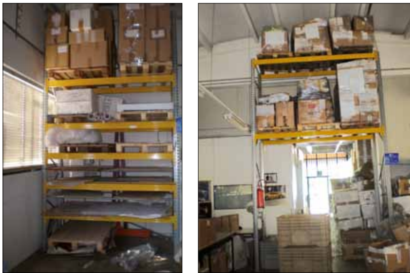
Figura 4.36. Scaffalature caricate in un edificio prefabbricato ad uso industriale con carico concentrato nella parte superiore della struttura.
