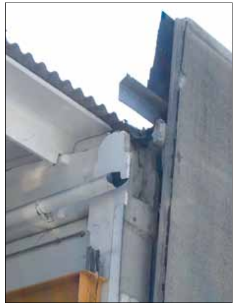
Figura 6.16: Esempi di danni ad elementi non strutturali secondari: (a) danneggiamento della rete elettrica (Mirandola (MO), settembre 2012); (b) danneggiamento di una tubazione a causa del collasso della tamponatura esterna (terremoto Emilia-Romagna 2012, Mirandola (MO))
