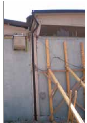
Figura 5.16: Perdita di appoggio della trave di copertura di un edificio monopiano prefabbricato a causa della crisi a taglio del pilastro di appoggio avvenuta in corrispondenza della variazione di rigidità causata dai tamponamenti non a tutta altezza. Livello di danno nella connessione trave-pilastro: D4 - D5 (terremoto Emilia-Romagna 2012)
