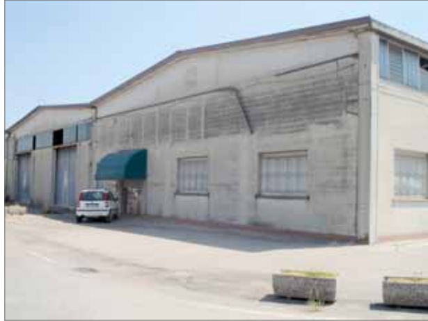
Figura 4.29. Struttura prefabbricata monopiano con tamponatura in laterizio.
