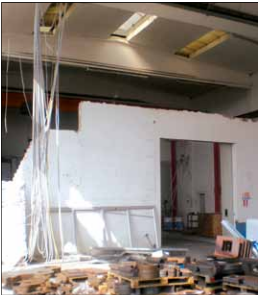
Figura 6.16: Esempi di danni ad elementi non strutturali secondari: (a) danneggiamento della rete elettrica (Mirandola (MO), settembre 2012); (b) danneggiamento di una tubazione a causa del collasso della tamponatura esterna (terremoto Emilia-Romagna 2012, Mirandola (MO))
