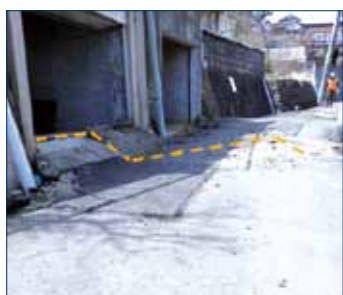
Figura 7.13: Distorsione della superficie del suolo sul fondo di un pendio instabile a Midorigaoka (Sendai) (Giappone 2011)
