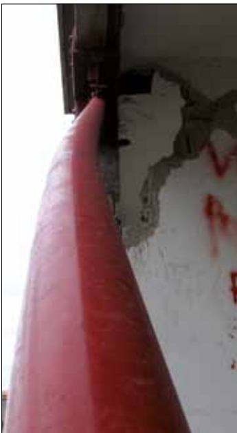
Figura 5.45: Esempio di danneggiamento dei controventi metallici: livello di danno D3.
